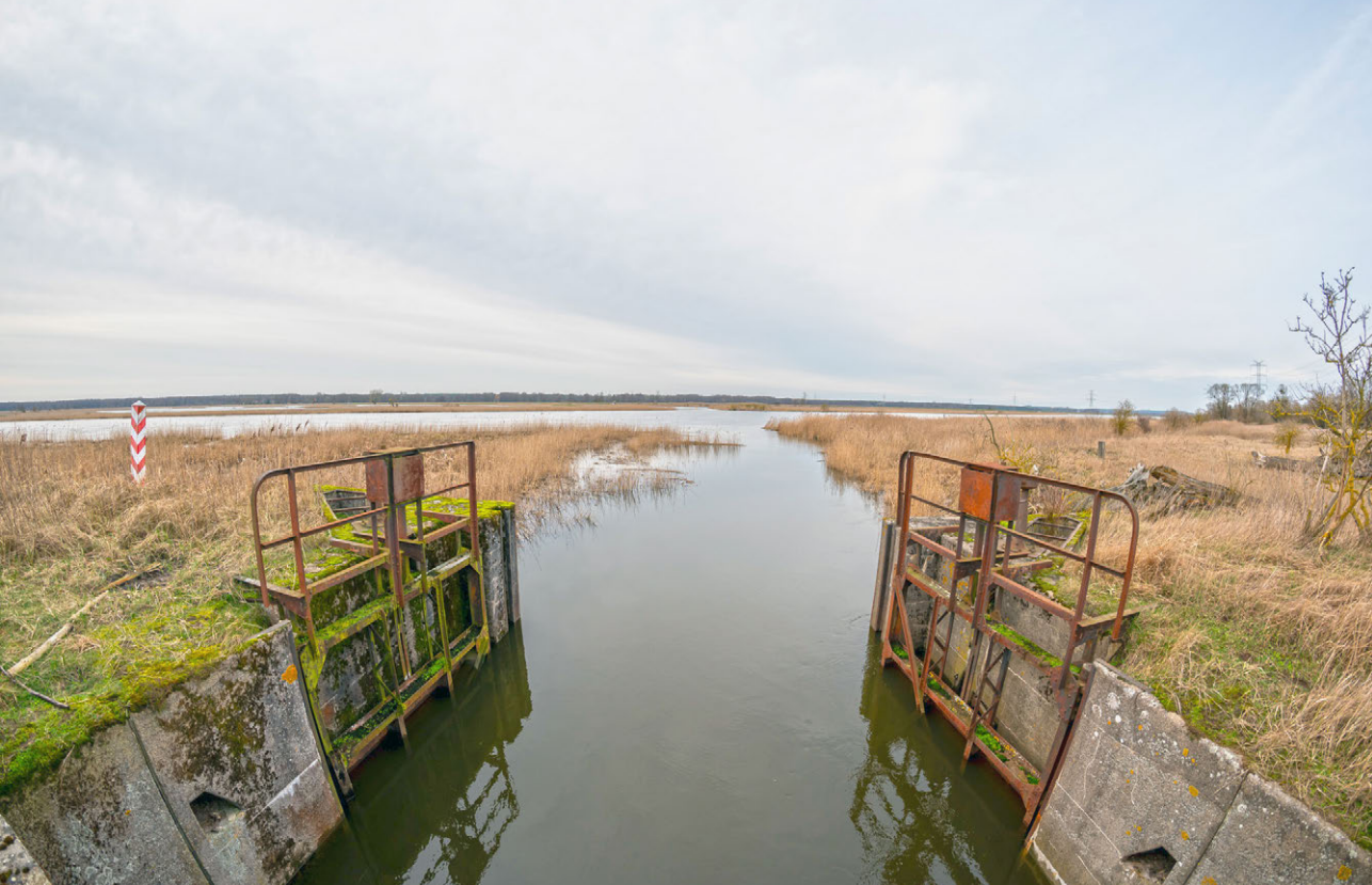
Fot. 8.4. Śluza na Odrze Zachodniej na północ od jazu w Widuchowej, widok w stronę rzeki (fot. Piotr Piznal)
