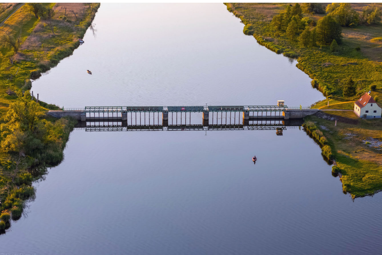
Fot. 8.1. Jaz w Widuchowej ograniczający przepływ wód do Odry Zachodniej (fot. Piotr Piznal)
