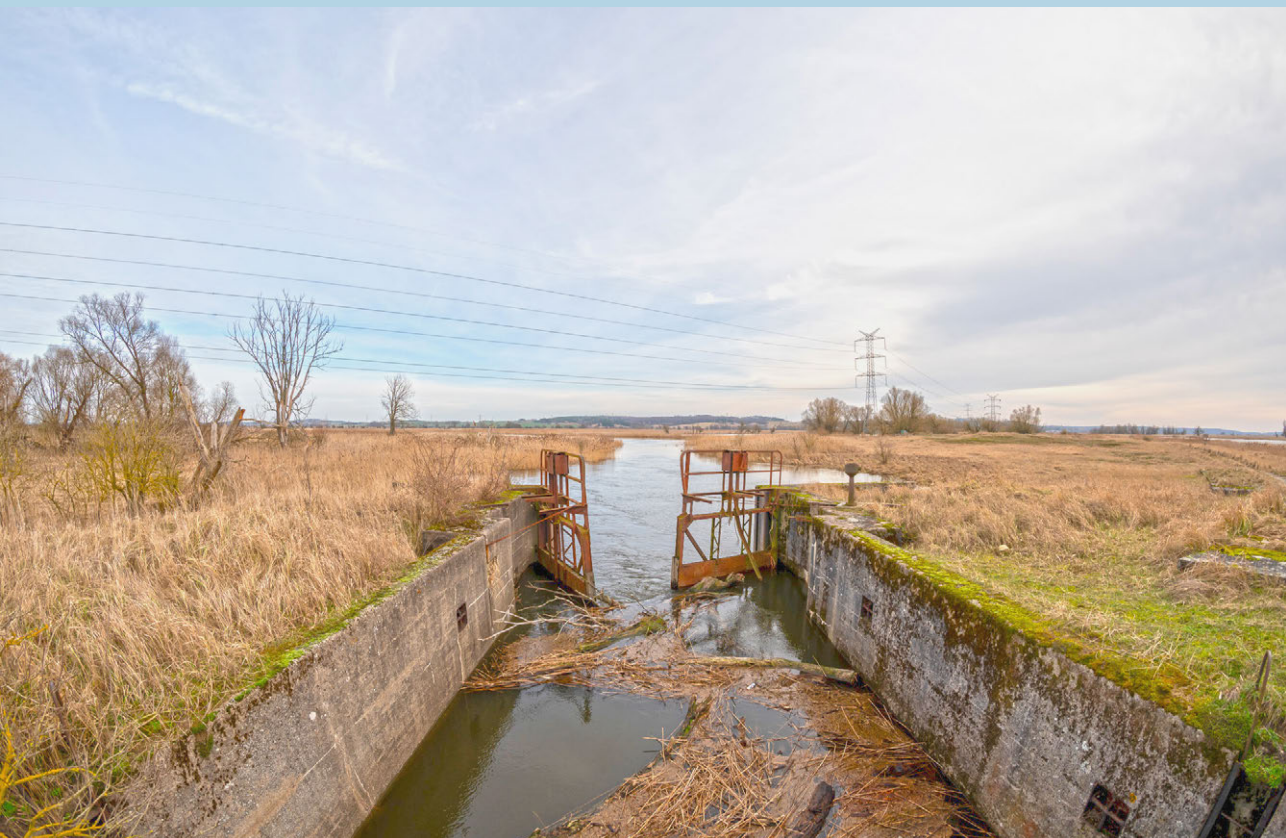
Fot. 8.5. Śluza na Odrze Zachodniej na północ od jazu w Widuchowej. Takie obiekty wymagają usuwania gromadzących się gałęzi i osadów (fot. Piotr Piznal)
