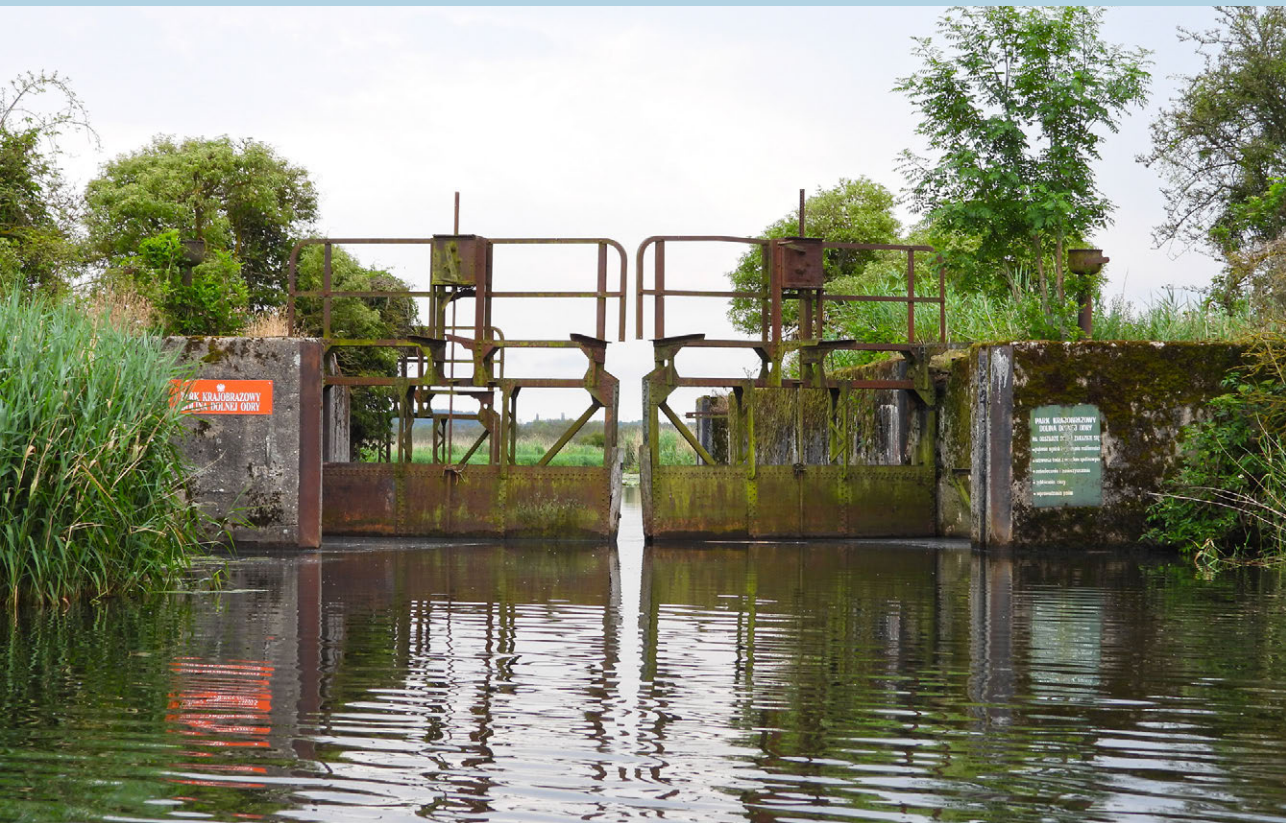
Fot. 8.7. Śluza Kamieniecka. Wrota samoczynnie otwierają się lub zamykają, w zależności od kierunku przepływu wody przez Międzyodrze (zasoby Zespołu Parków Krajobrazowych Województwa Zachodniopomorskiego)
