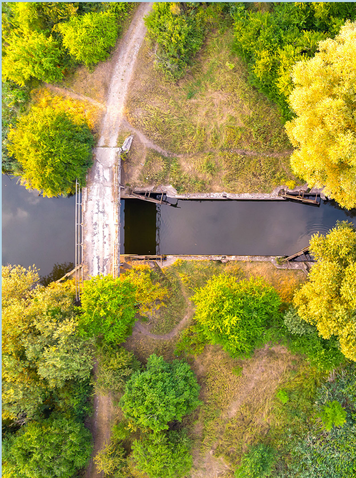
Fot. 10.10. Pływająca opaska, zainstalowana na słuzie, zabezpieczyła Międzyodrze przez wpływaniem martwych ryb
